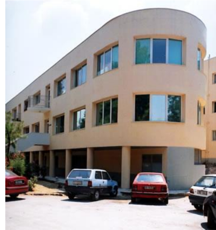
Σανατόριο «Σωτηρία», Λεωφόρος Μεσογείων 152, 1932-37. Γενική άποψη.
