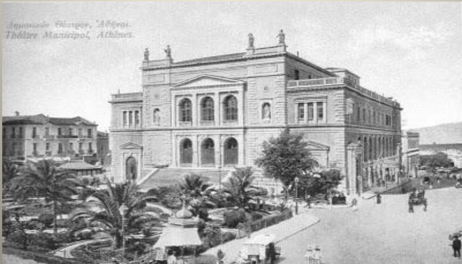
Ερνέστος Τσίλλερ, Δημοτικό θέατρο Αθηνών. Κατεδαφίστηκε το 1940.
