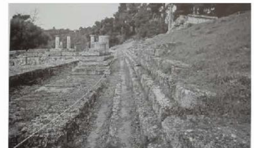
Δυτικό τμήμα κρηπίδας: Άποψη από Α.
