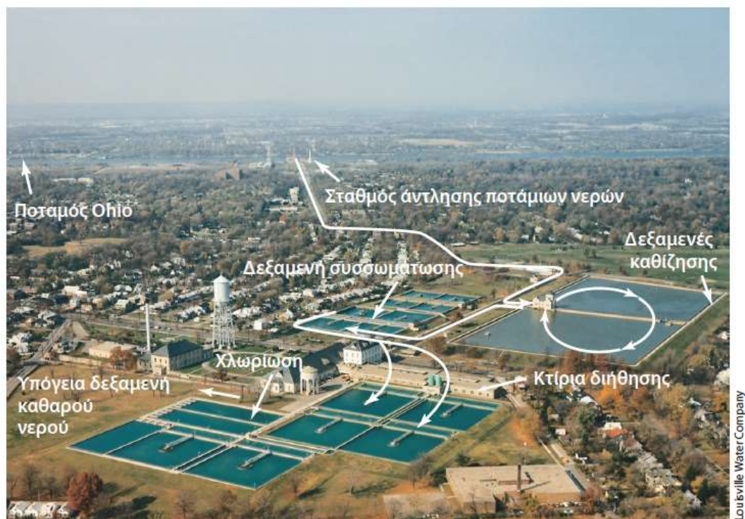
Εικόνα 21.19 Μονάδα καθαρισμού νερού. (α) Από αέρος, εικόνα μιας μονάδας επεξεργασίας νερού στο Louisville, στο Kentucky των ΗΠΑ. Τα βέλη υποδεικνύουν την πορεία της ροής του νερού μέσα στη συγκεκριμένη μονάδα. (β) Σχηματική αναπαράσταση ενός τυπικού συστήματος καθαρισμού νερού.
