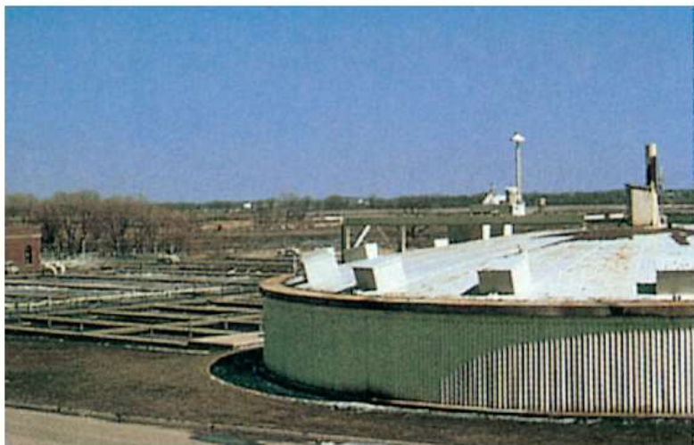
Εικόνα 21.15 Δευτεροβάθμια αναερόβια επεξεργασία υγρών αποβλήτων. (α) Αναερόβιος χωνευτήρας ιλύος. Παρουσιάζεται μόνον το επάνω μέρος της δεξαμενής· τα υπόλοιπα τμήματα είναι υπόγεια. (β) Εσωτερική λειτουργία ενός χωνευτήρα ιλύος. (γ) Οι κύριες μικροβιακές δράσεις κατά την αναερόβια χώνευση της ιλύος. Τα κύρια προϊόντα της αναερόβιας βιοαποικοδόμησης είναι το μεθάνιο ( \text{CH}_4 ) και το διοξείδιο του άνθρακα ( \text{CO}_2 ).
