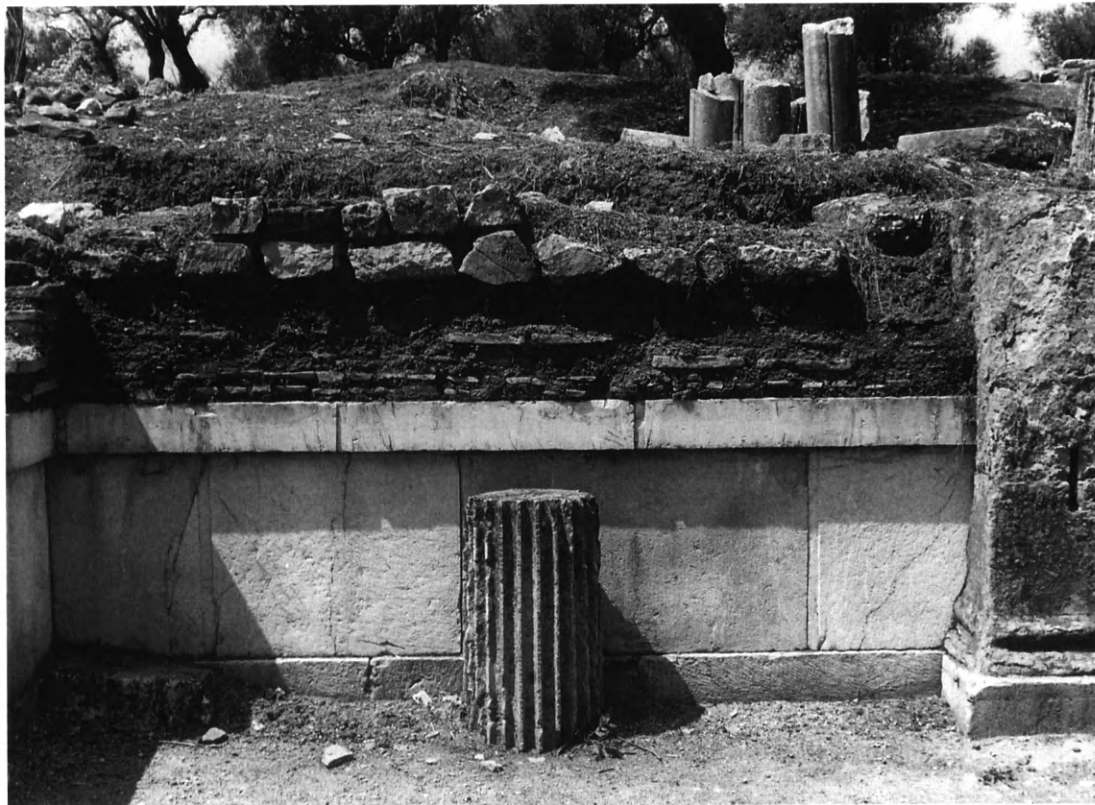
Εἰκ. 28. Ἀποψη τμήματος τοῦ δυτικοῦ τοίχου μὲ ὀπτοπλινθοδομή.
