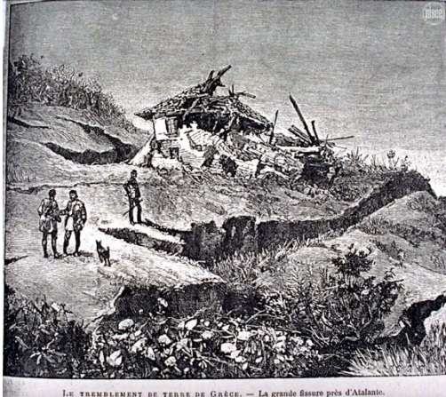
LE TREMBLEMENT DE TERRE DE GRÈCE. — La grande fissure près d'Atalante.
