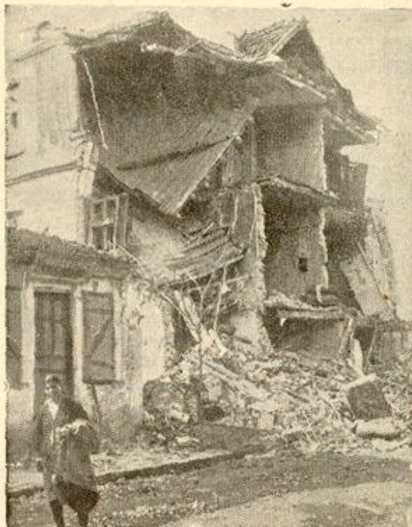
Μία άποψις οίκιας μετά την κατεδάφισιν τῶν ἐτοιμορρόπων τοίχων της.
