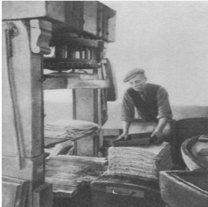
5. Pressen: Papier kommt in eine Papierpresse, damit das Wasser rausgepresst wird
