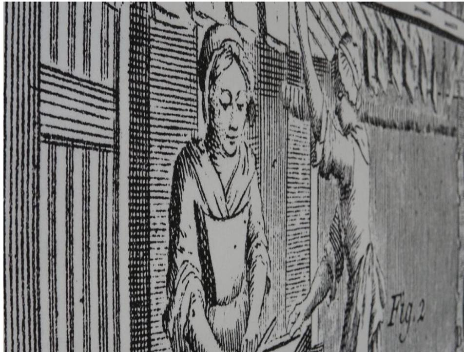
7. Oberfläche des Papiers wird mit Glas oder einem glatten Stein verfeinert, um das Papier tintenfest und haltbar zu machen
