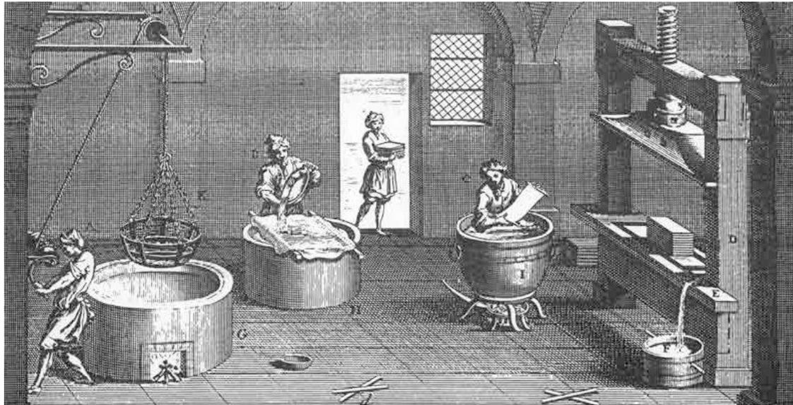
1. Lumpen werden gesammelt, zerkleinert und in einem Behälter mit Wasser ca 2 Wochen aufbewahrt. Sie "rotten vor sich hin." Dieser Prozess heißt Faulung.
