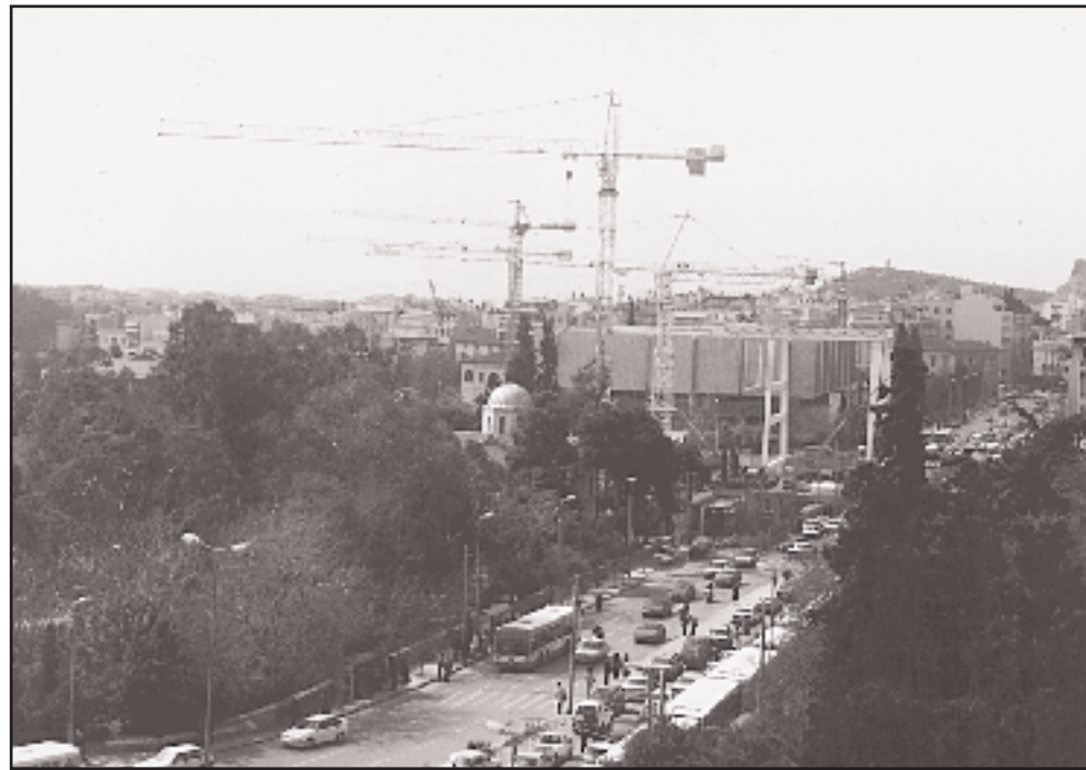
Τα έργα του μετρό απαιτούν την ύπαρξη μηχανημάτων τελευταίας τεχνολογίας... Στη Βασ. Σοφίας, γερανοί στέκονται σαν τους... πελεκάνους όρθητοι, στηθοί και μετακινούν βαριά μηχανήματα...
