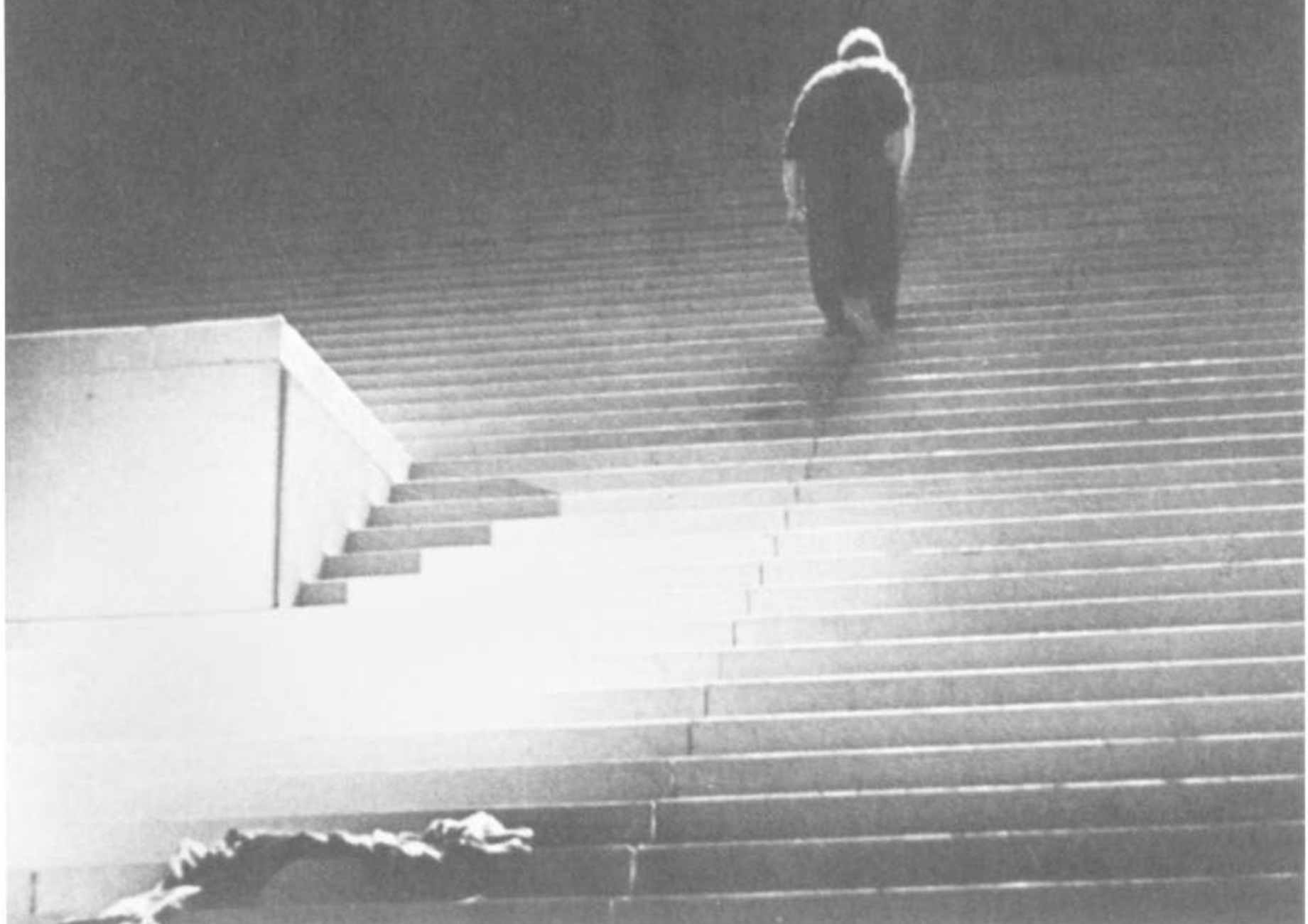
Josef Svoboda, Oedipus King , Prague, 1963, η τελευταία σκηνή του έργου. Μια ορχήστρα κάτω από τις σκάλες συνόδευε τη δράση. Προκειμένου να ακουστεί σωστά, τα σκαλοπάτια της σκάλας ήταν κατασκευασμένα από ακουστικά «διαφανές» υλικό παρόμοιο με αυτό που βρίσκεται στην πρόσοψη πολλών περιβλημάτων ηχείων.
