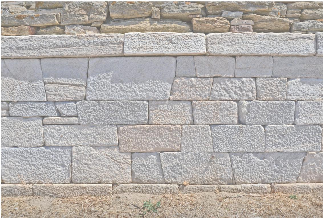
Fig. 13. La salle hypostyle, partie basse du parement intérieur du mur nord, avec plinthe et bandeau de couronnement : appareil trapézoïdal avec de rares décrochements et un parement piqueté (cl. J.-C. Moretti).
