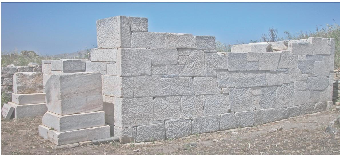
Fig. 10. Le temple d'Aphrodite : appareil trapézoïdal à décrochements avec parement piqueté (cl. J.-C. Moretti).
