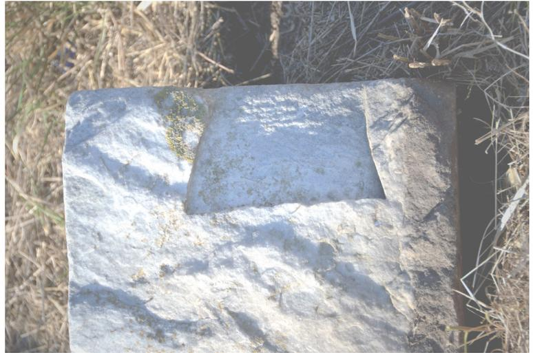
Fig. 4. Cavité de louve, brisée en hauteur, au lit d'attente du pilier 20 de la salle hypostyle (cl. J.-C. Moretti).
