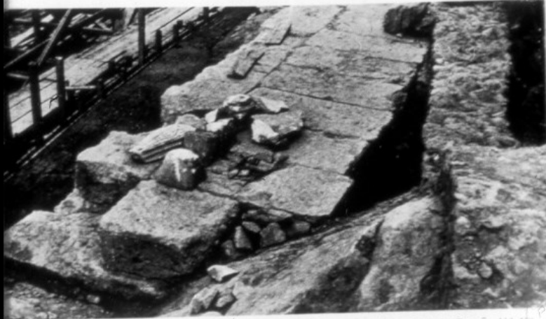
157 Teil der Stützmauer des Tempels der Artemis Agrotera, die einzige heute sichtbare Stelle der Reste in Abb. 156
